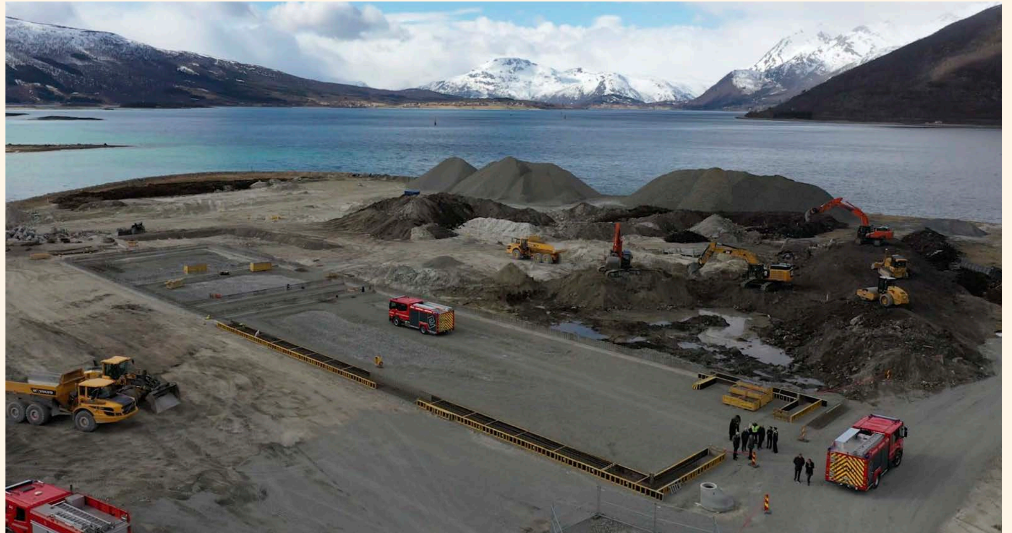
Utbygging av Brann- og redningsskolen i Tjeldsund.
