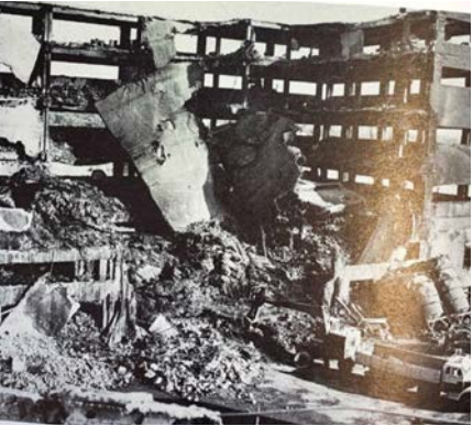
Oversikt over skadene i ferdigvarelageret. 3,5 mill. liter maling gått opp i røyk. Hvilken brannbelastning!
