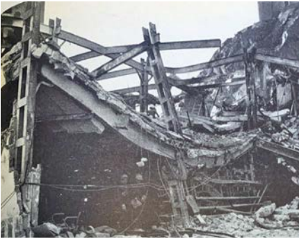
Søndre del av malingfabrikken (laboratoriet). Bemerk de bærende stålkonstruksjoner spesielt sammenkrøllingen av søylen midt på bildet.
