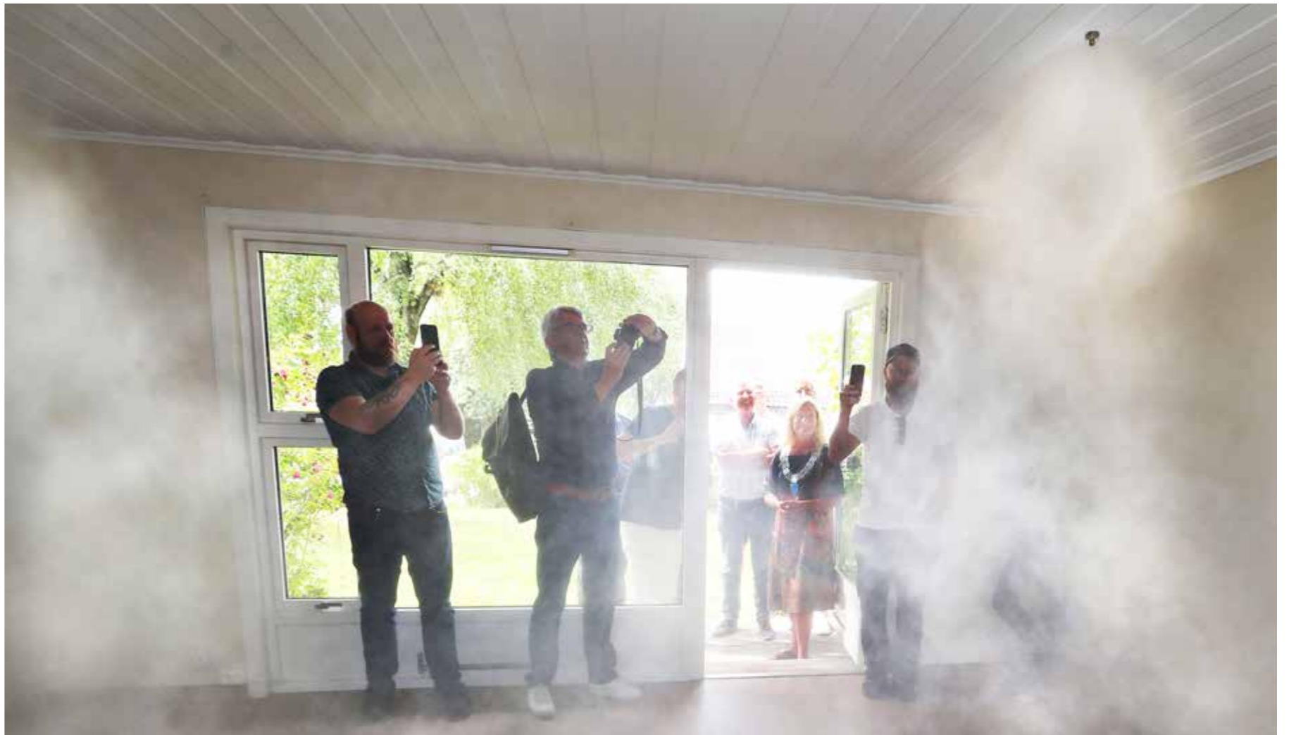
↑ I slutten av juni inviterte Tønsberg kommunale eiendom til demonstrasjon av et nytt automatisk slokkeanlegg basert på vanntåke.
