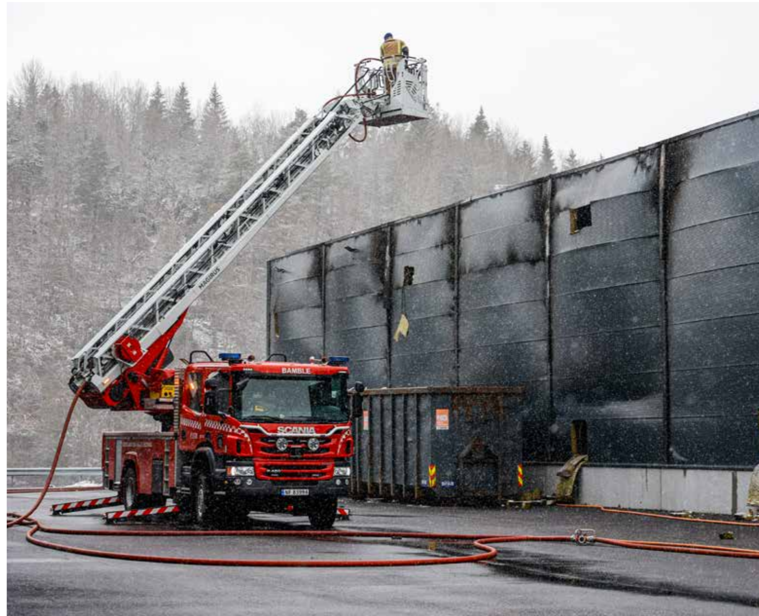
↑ En teknisk feil førte til at det var mangel på slokkevann for brannvesenet under brannen ved Elkjøp Langrønningen i vår. Bygget ble totalskadet i brannen..
