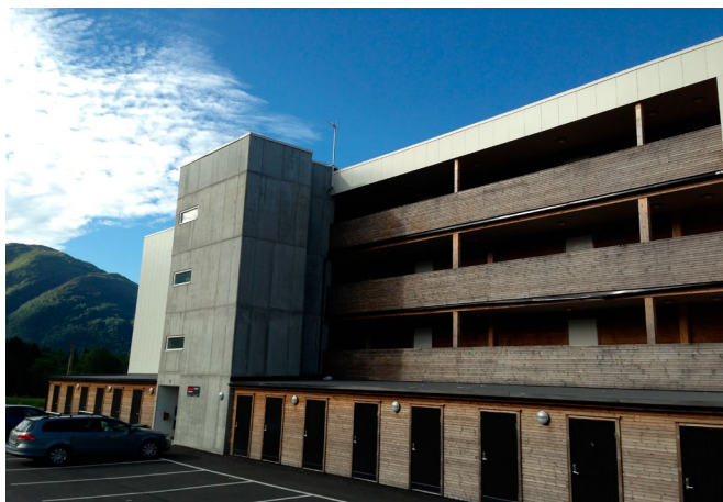
Figur 4-2: Foto av nord-østfasaden med trapperom og svalganger. Bak dørene på grunnplanet er det boder. Bildet er tatt av Bergen kommune i forbindelse med befaring i 2012, brukt med tillatelse.
