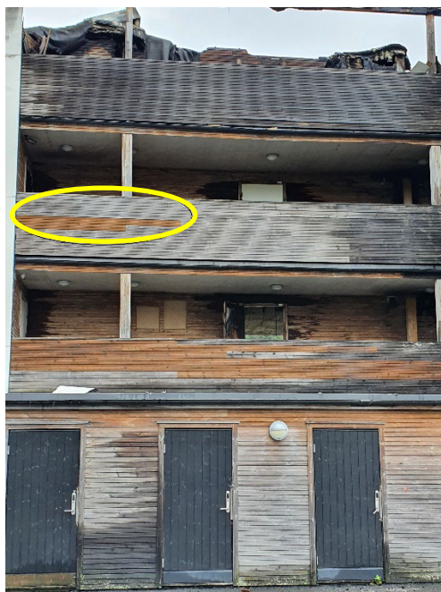
Figur 4-3: Nord-østsiden av bygget med svalganger etter brannen. Området kledningsmaterialet til testing ble hentet fra er markert med gult. Foto: RISE Fire Research/FRIC.
