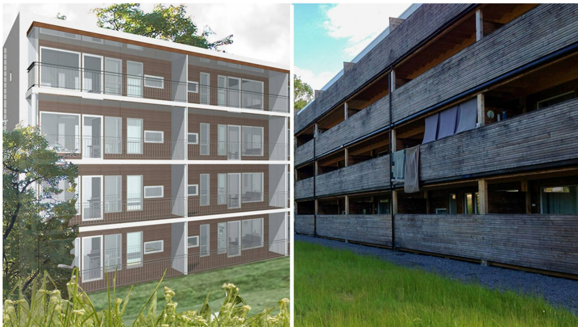
Figur 3-2 Utsnitt av tegning av opprinnelig planlagt fasade med balkonger til venstre, og bilde av ferdigstilt bygg til høyre (foto: Bergen kommune).
