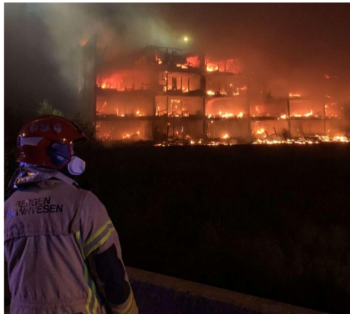
Figur 1-1: Fasaden mot sør om lag to timer etter at brannen ble varslet. Foto: Bergen brannvesen, brukt med tillatelse.
