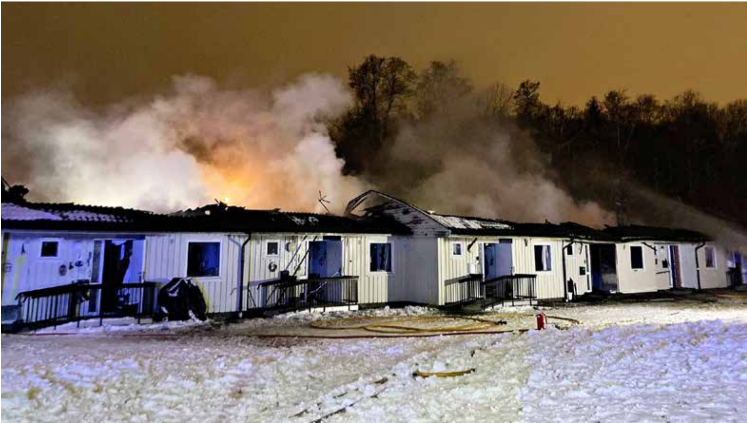
← I desember 2021 brant det i omsorgsboligen i Granatveien i Tønsberg kommune.
