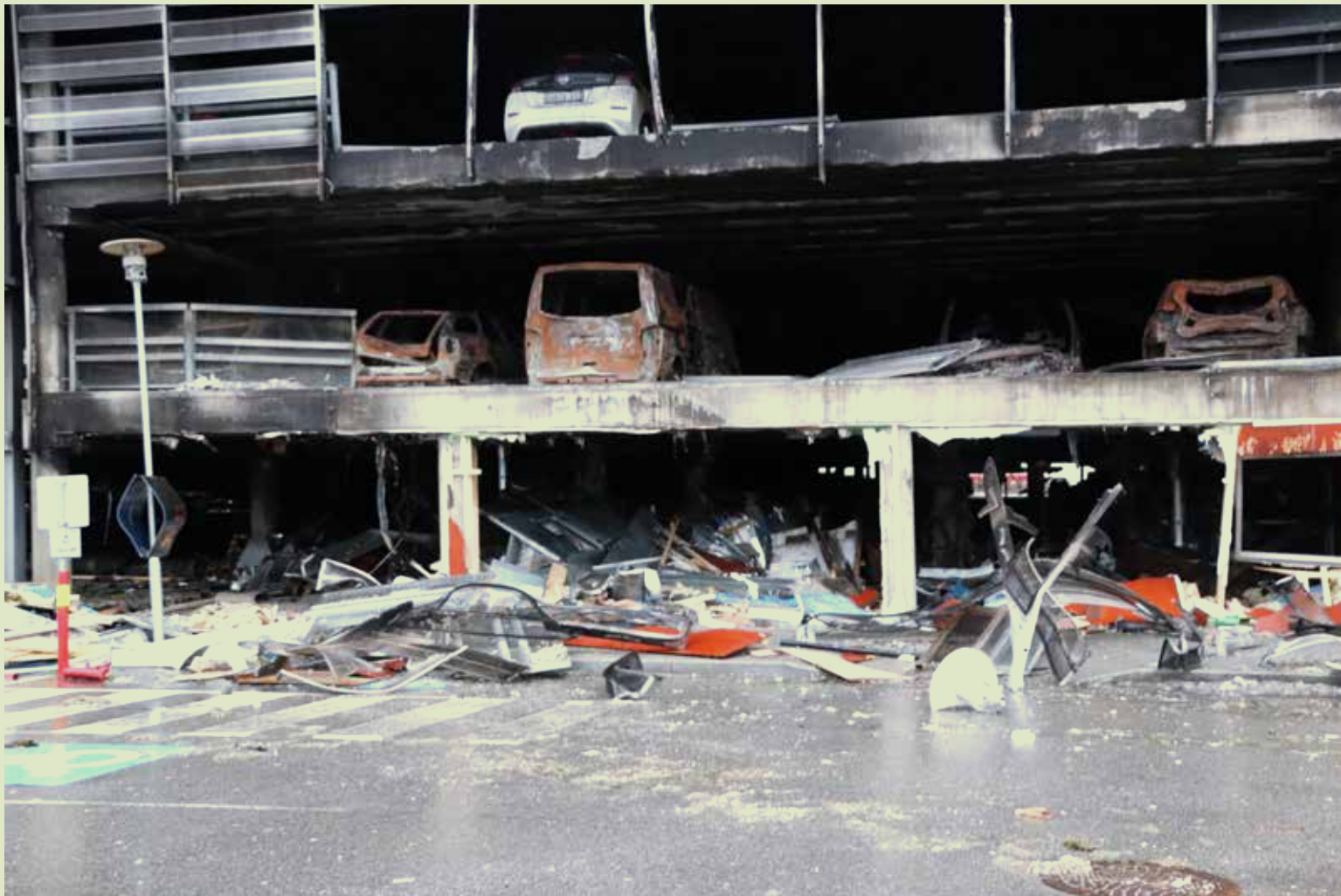
← Slik så det ut i parkeringsgarasjen ved Stavanger lufthavn, Sola etter brannen 7. januar 2020.
