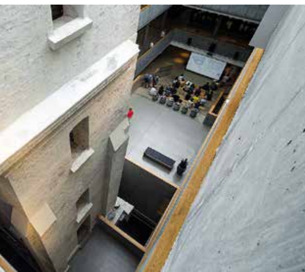
← Rådhuskvartalet i Kristiansand har vært dominert av branntårnet i tilknytning til brannstasjonen i over 120 år. Da kvartalet ble rehabilitert, ble branntårnet integrert.
