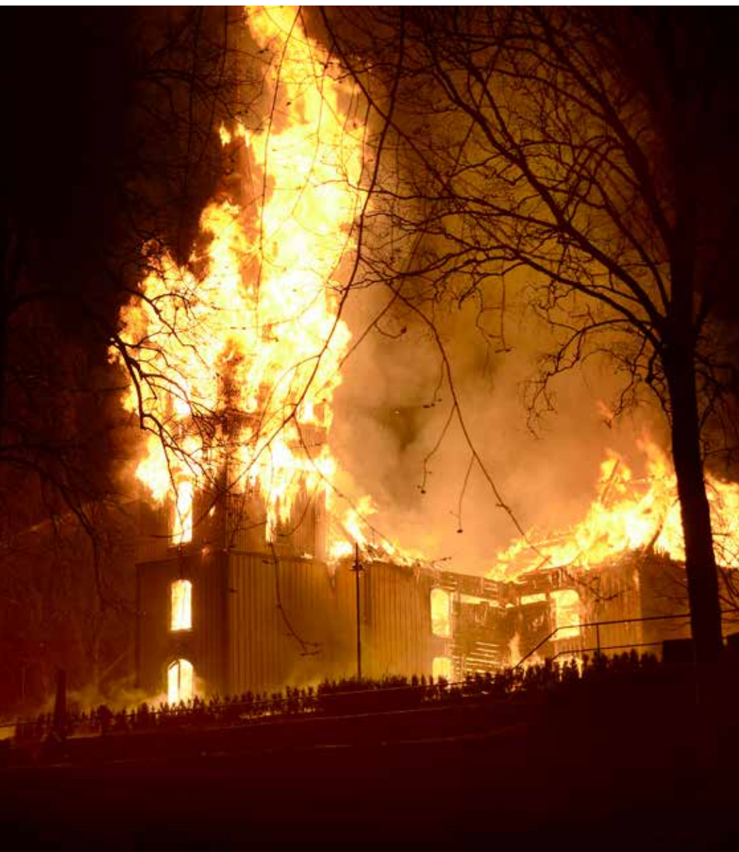
← Natt til 11. april 2011 ble Østre Porsgrunn kirke totalskadet i brann, og to tenåringer ble tiltalt og dømt for å ha tent på kirken.
