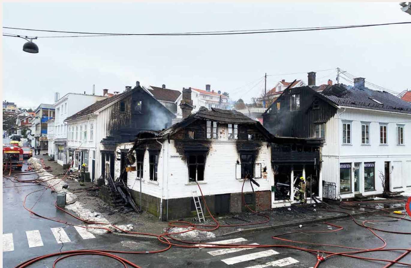
↑ Tre bygg ble totalskadd i brannen i Storgata i Risør natt til 24. februar.
