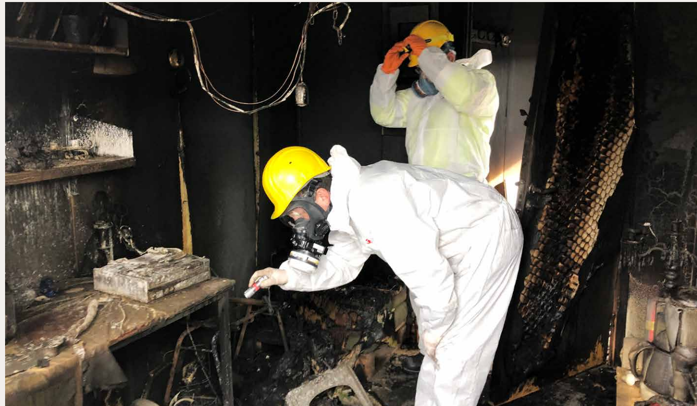
Foto: Oslo brann- og redningsetat
