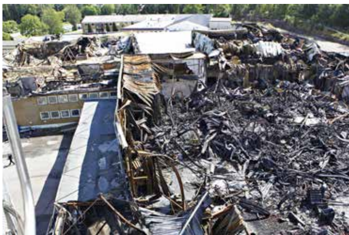
Basa-Huset i Tønsberg ble total-skadet i brann i 2015. Nå er byggeier frikjent for erstatningskrav.
