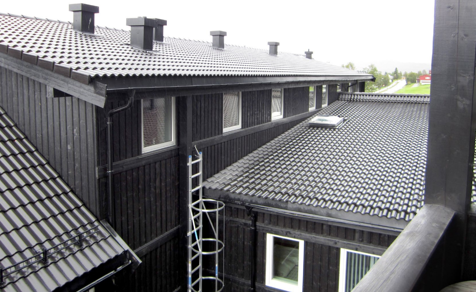
Åtte seksjoner i Geilo Gaarden fikk bruksforbud på grunn av feil og mangler ved rømningsveier.
