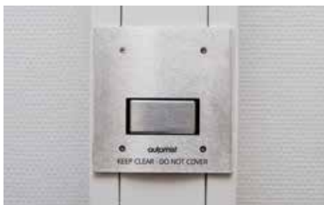
Høytrykksdysa med IR-kamera skanner leiligheten. Ved varmeutvikling, vil pulverisert vann settes direkte mot varmekilden.
